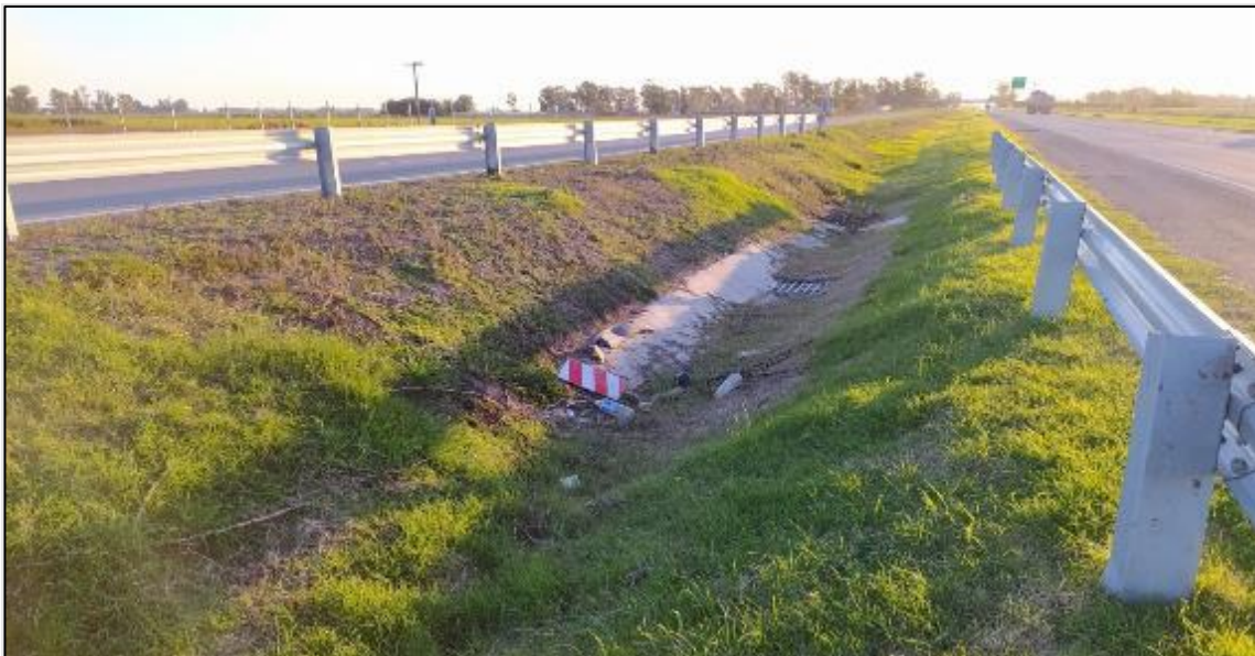
Figura 12. Alcantarilla en cantero central. Fuente: JST
